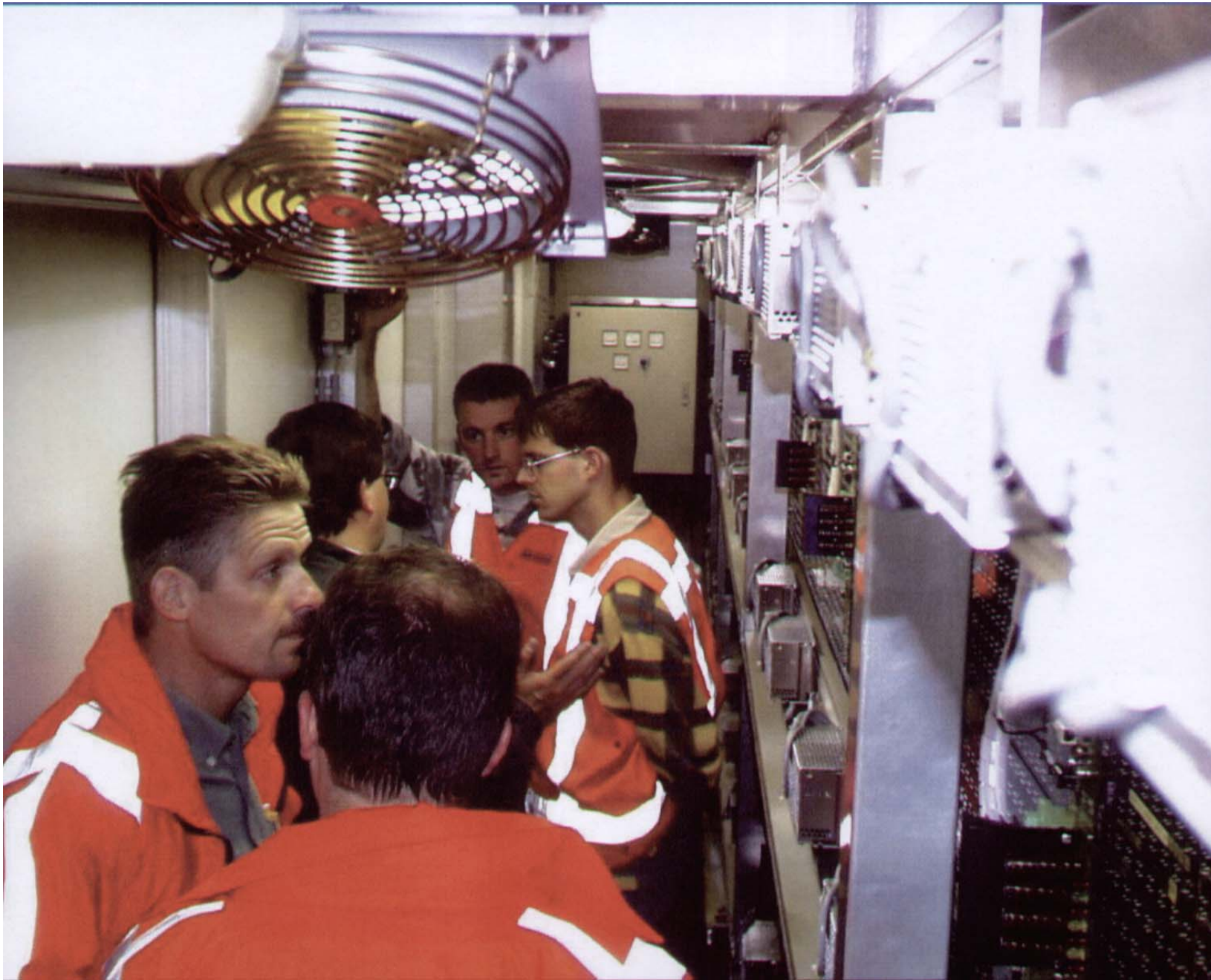
Járható portál (az előző objektum belülről)
